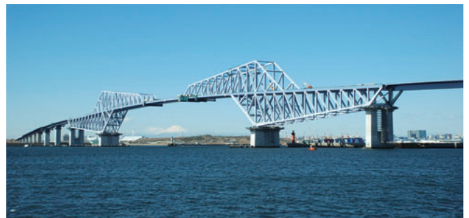
SBHS 鋼用溶接材料が採用された東京ゲートブリッジ (国土交通省関東地方整備局東京港湾事務所提供)
