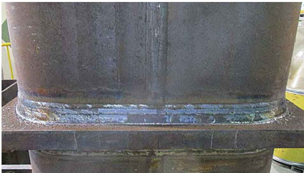
写真 3 SX-55 の溶接外観
