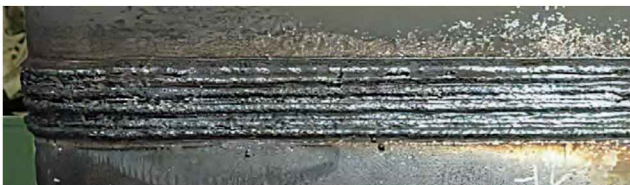
コラム溶接直線部
