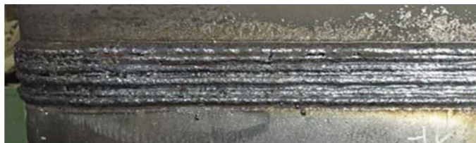
コラム溶接直線部
