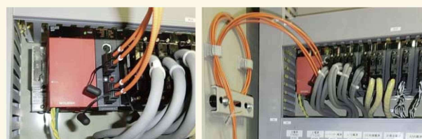
工場に MELSEC に使用されるピコケーブルの使用例写真
