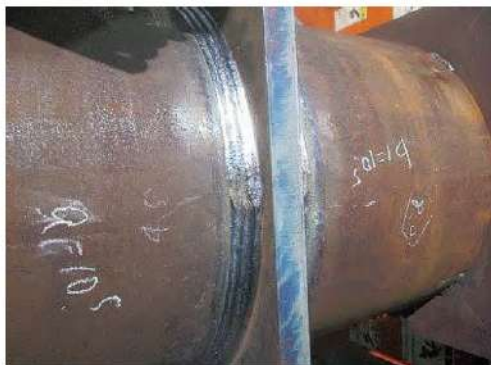
写真8 円形鋼管×SX-26の溶接外観
